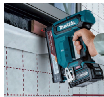
外装下地 / 軒天仮留め
